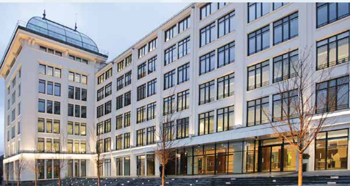
📍 Nouveau site de l'OCDE, Boulogne-Billancourt.
