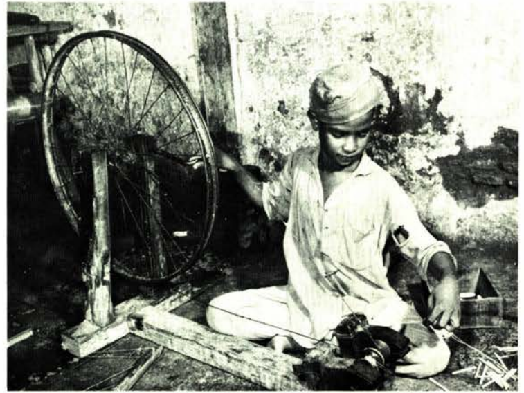
Un jeune garçon prépare des bobines de fil pour tissage à domicile. Il a lui-même construit le rouet à partir d'une vieille roue de bicyclette.
