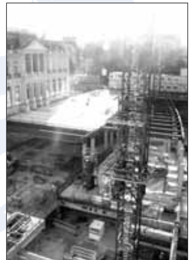
De bonnes perspectives en vue pour le nouveau Centre de conférence : les travaux avancent rapidement.
