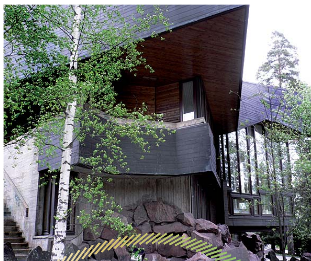
La façade ouest de Dipoli, l'Institut d'apprentissage tout au long de la vie de l'université
