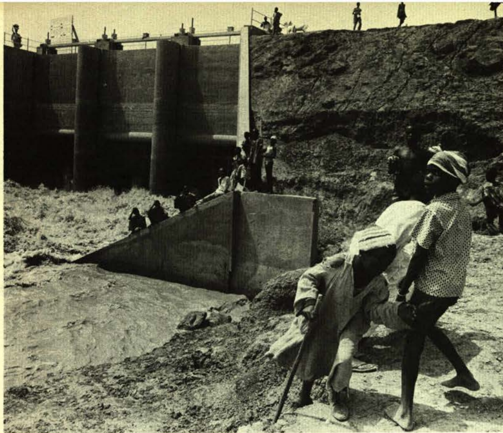
Le barrage Fom Gleita à Keidi en Mauritanie, financé en grande partie par le Fonds européen de développement.
