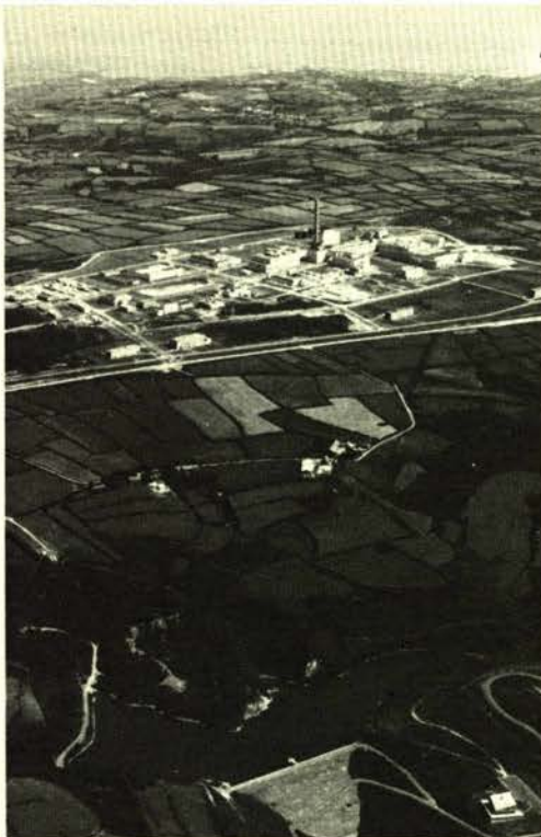
L'usine de retraitement de la Hague (France) assure la séparation du plutonium et de l'uranium contenus dans le combustible nucléaire irradié.
