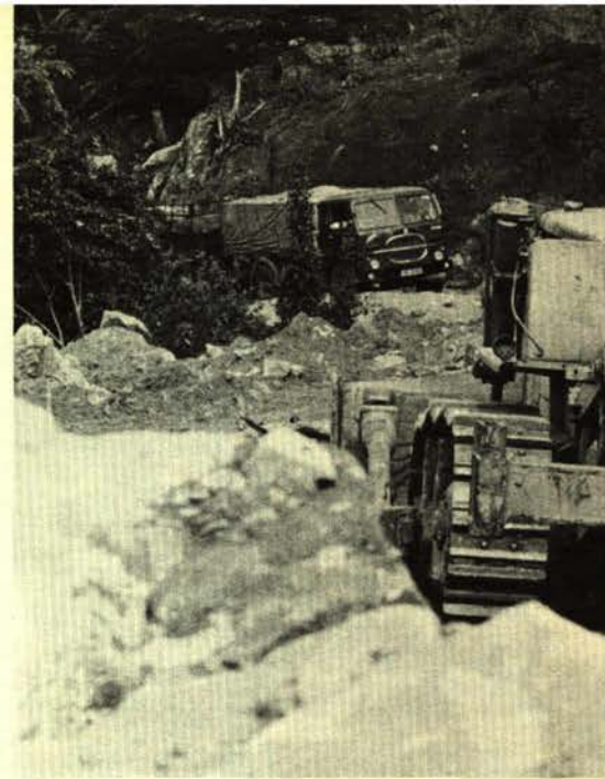
La construction de la route Tan-Zam,
