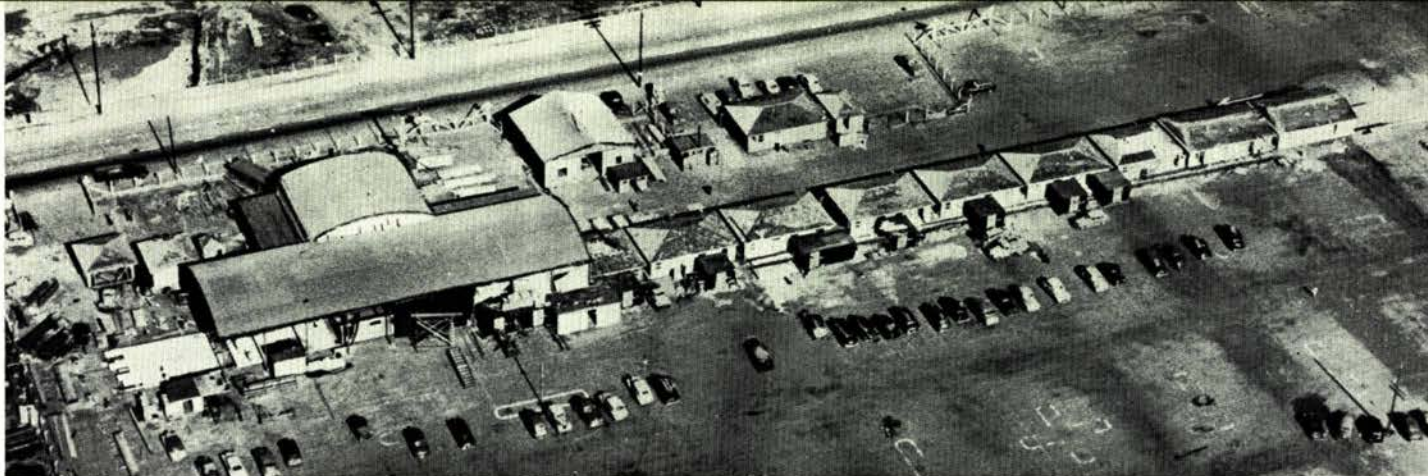
Une « chaîne de montage » : sous le hangar, pose du plancher ; à droite une maison terminée.
