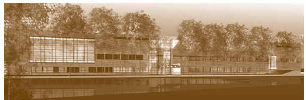
Le Centre de transformation sur le bois ouvré (CTBO)
